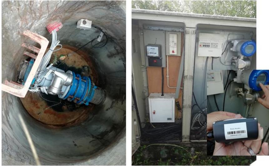
Figura 2 – Ponto de medição existente (KROHNE – TIDALFLUX 2000)
